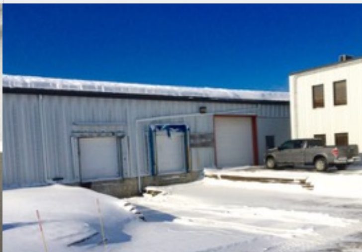
Quais de chargement (2) et porte au sol
